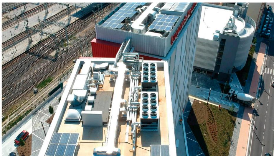
**Figura 7** – Disposizione in copertura dei gruppi polivalenti, delle UTA con vista dei canali e delle reti idroniche (schema costruttivo e foto aerea)
